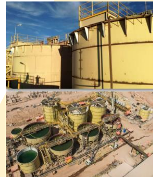
Planta Leaching Agitación EPC (CN-) de 45,00t/m de Au/Ag para Guanaco – Compañía Minera Astro Gold
